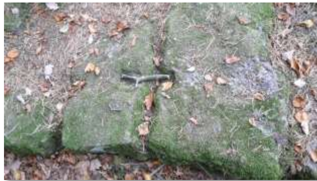
A : Face de travail étagée B : Entaille longitudinale pour détacher les blocs C : Entaille faites avec des cales
