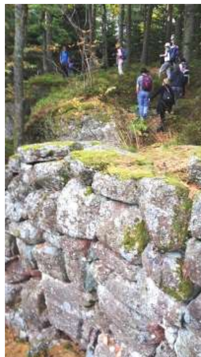
Abb. 6/7: Der Größenvergleich verdeutlicht die gewaltigen Dimensionen der Heidenmauer.
